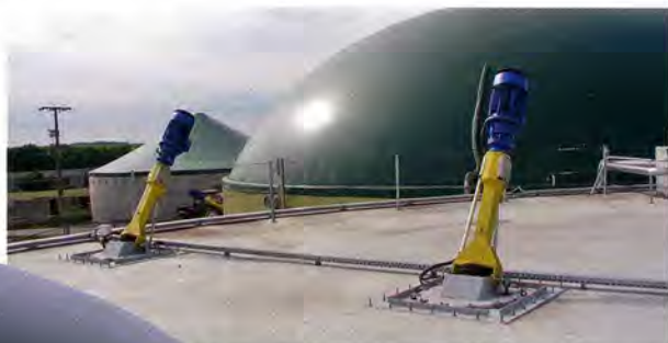
Pro Behälter halten zwei Propeller-rührwerke das Substrat in Bewegung. Sie lassen sich von außen ohne Unterbrechung des Betriebs warten.
