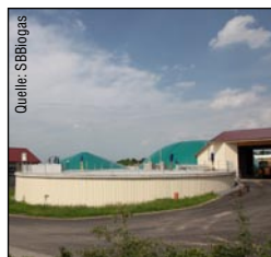
Quelle: SBBiogas Mehr Biogas: Anlage mit Kombifermentation
